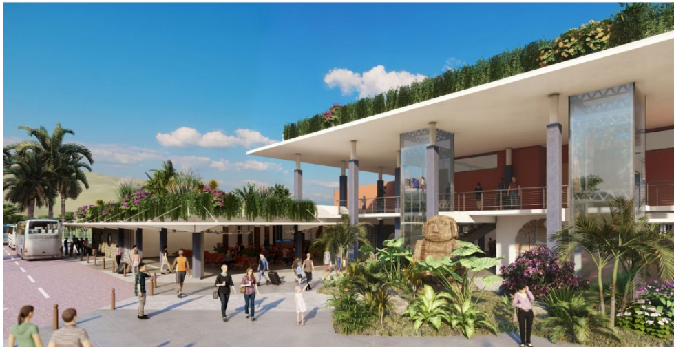
Figure 18. Vue sur l'entrée principale du Terminal de Croisière International
